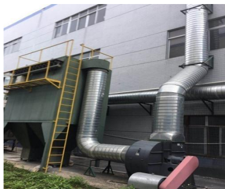
抛光和喷砂废气处理设施
