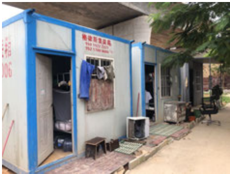
广深高铁项目部临时工棚
