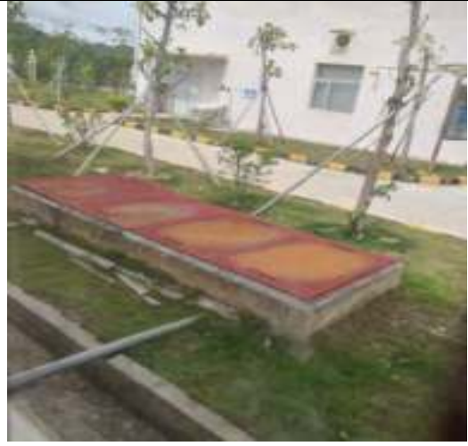
化学品仓、危废仓事故应急池
