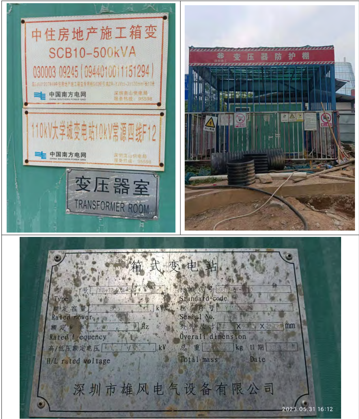
图 3.6-1 变压器标识牌
