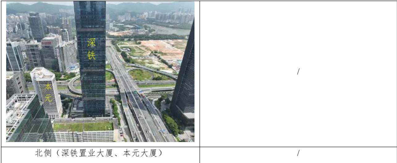
图 2.5-1 相邻地块现场踏勘照片
