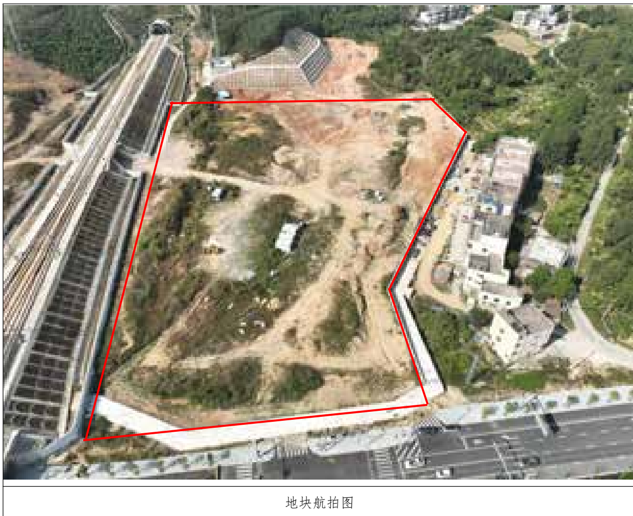
图 2.5-1 地块现场踏勘照片
