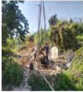
钻探施工现场
