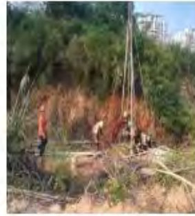
钻探施工现场
